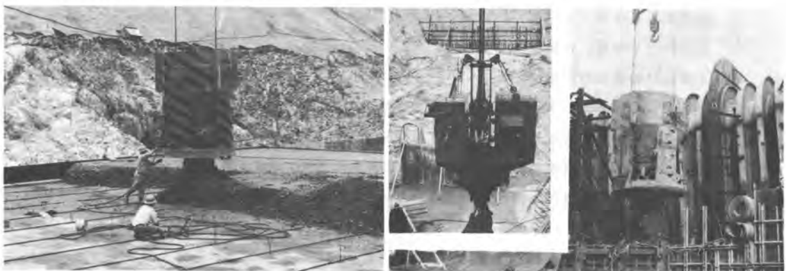
写真-1 従来のコンクリート打設状況
