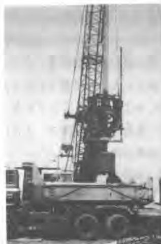
写真2 自動排土装置使用状況
