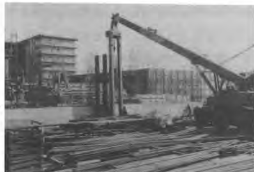
写真-3 引抜き状況
