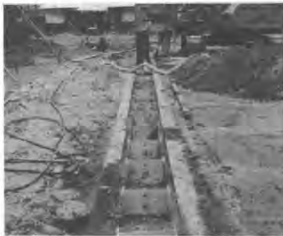
写真-2 埋設状況
