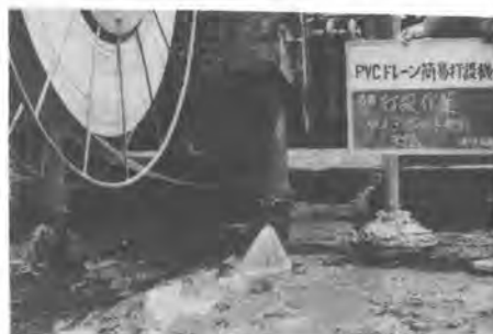
写-3 先端マンドレルからウォータジェット噴射
