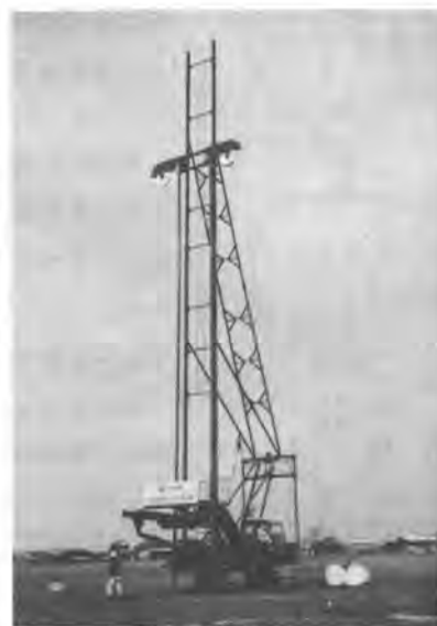
写真1 改良したO Vドレーン打設機
