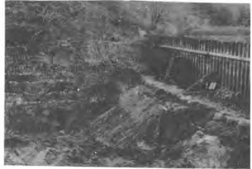
写真-2 GL-9.0 m 付近の掘削状況
