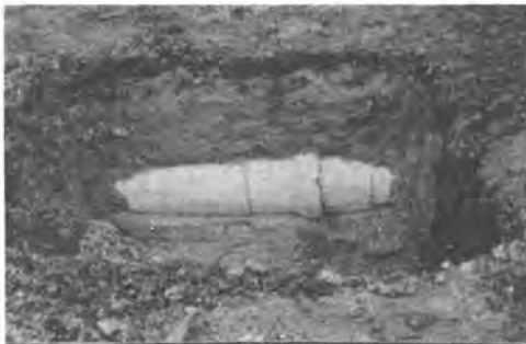
写真 3 PSS工法 ヒューム管の囲りと固化後削削
