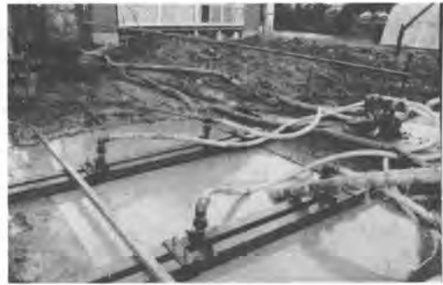
写真-2 吐出管等の配置例 (PSS工法)
