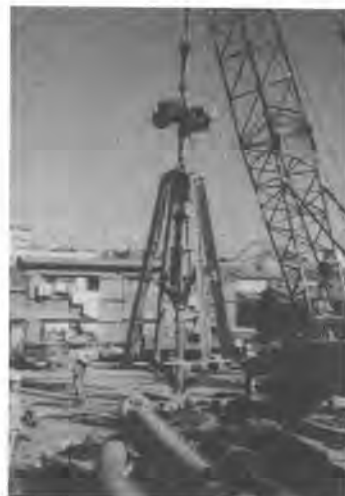
写真-1 TKR拡底ビット (ビット径 4.1m)
