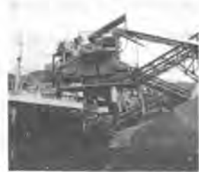
写-2 生コン工場稼働状態
