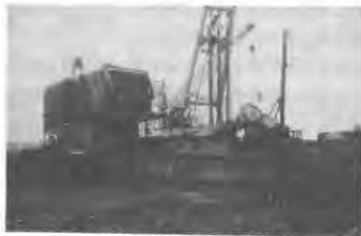
図-6 泥水処理システム設置状況
