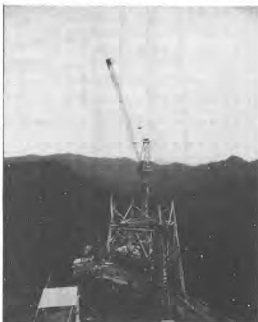
写真-1 CT45クライミングクレーン
