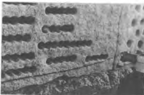
写真-2 スロット
