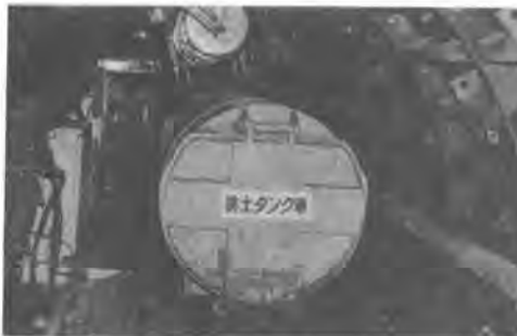
写真-1 掘進状況
