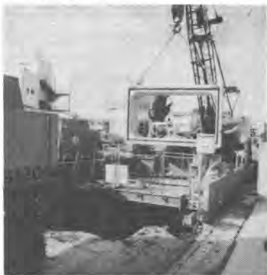
巨大ボックス・カルバートの埋設状況
