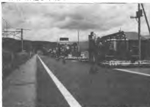
写真-3 実施工風景 国道17号線
