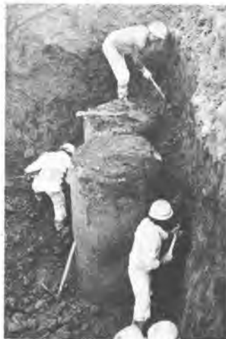
写真-3 改良後の地盤 ( \phi 1000 )
