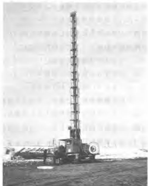
写真-1 施工機械
