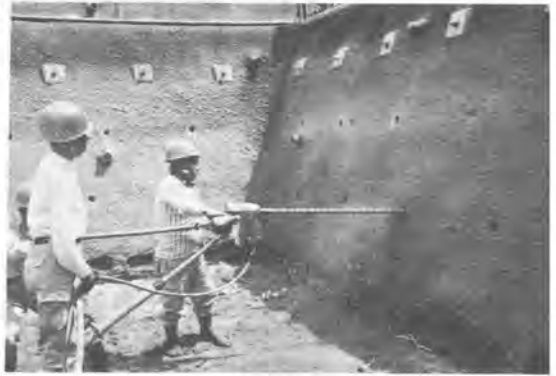
写真-2 レッグハンマーによる穿孔
