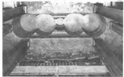
写真-1 孔壁状況
