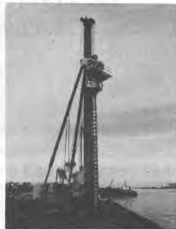
写真-1 砕石ドレーン施工機の全景
