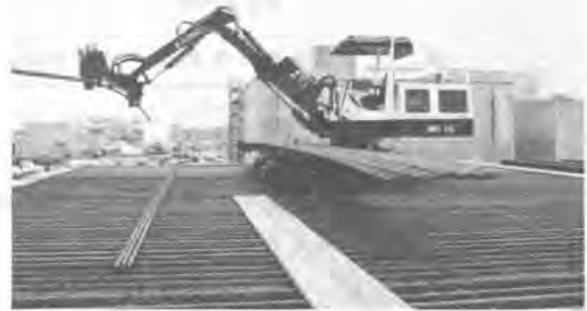
写真-1 重量鉄筋用配筋ロボット外観
