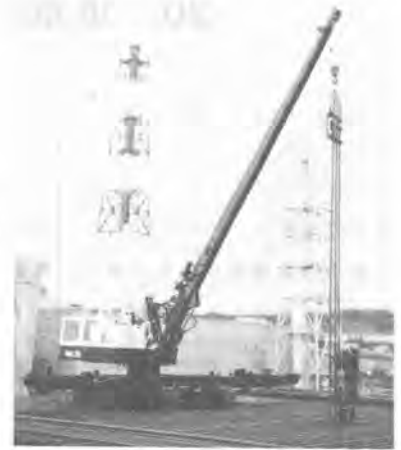
写真-2 クレーンアタッチメント交換による垂直配筋作業状況
