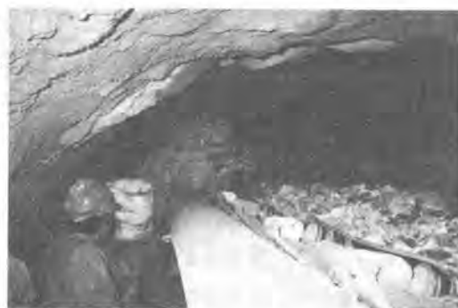
写真-1 カッターヘッド直後の吹付け作業
