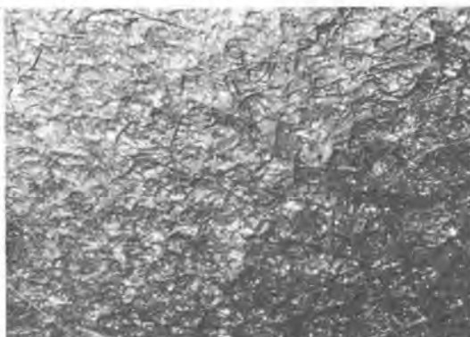
写真-4 仕上面の状況
