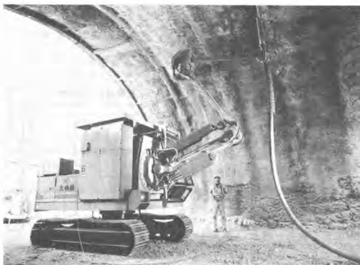
写真-1 ティーチング中のコンクリート吹付けロボット
