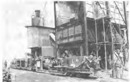
写真-1. K-Shot System 2号機(徳沢工)
