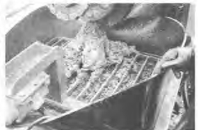
写真-4 硬練コンクリートのポンプへの投入
