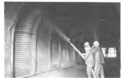
写真-3 模擬トンネル内吹付け状況
