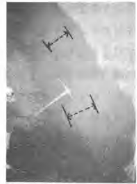
写真-6. 厚吹打況
