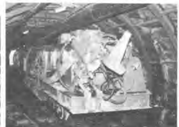
写真-8. 2号機トンネル掘削中の様子
