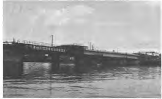
写真-1. 押し出し施工全景
