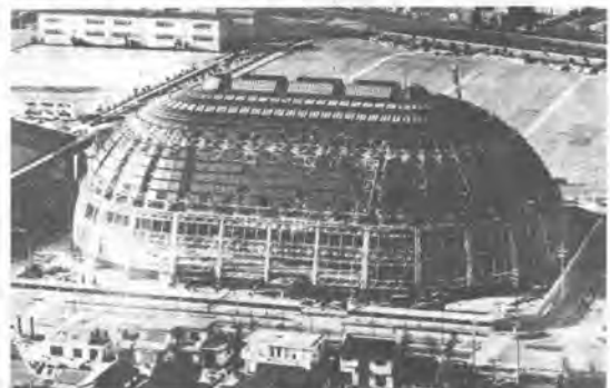
写真-3.2 プッシュアップ後の現場状況
