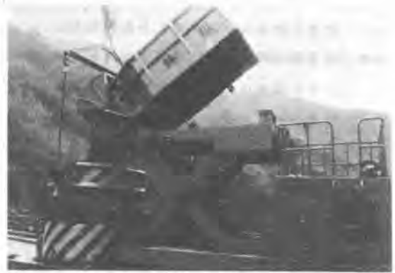
写真-2 コンクリート受入状況
