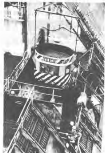
写真-1 コンクリート打設状況
