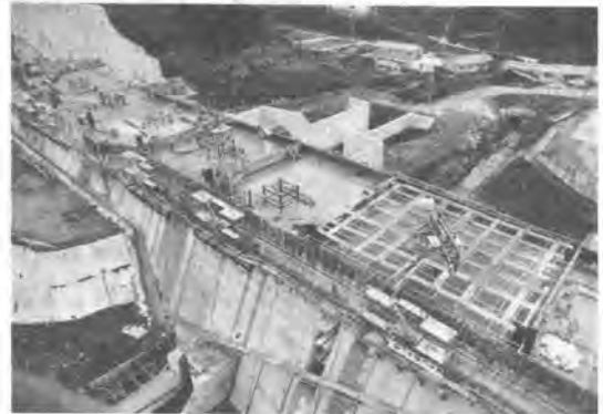
写真-2 打設用足場とディストリビュータ設置状況
