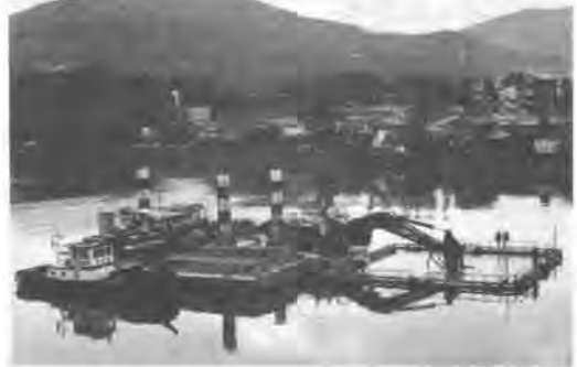
写真-1 作業全景
