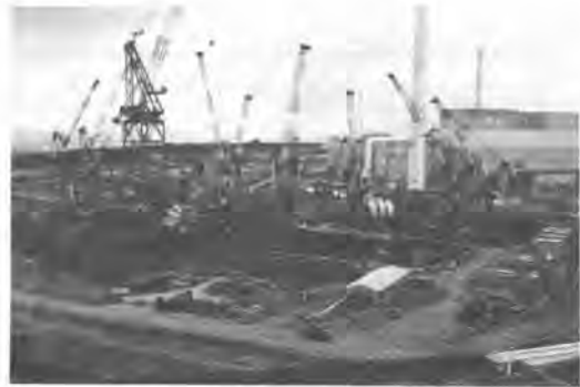
写真-1. タワークレーン稼働状況
