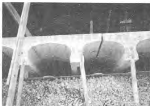
写真-3 据付られたπ型ブロック
