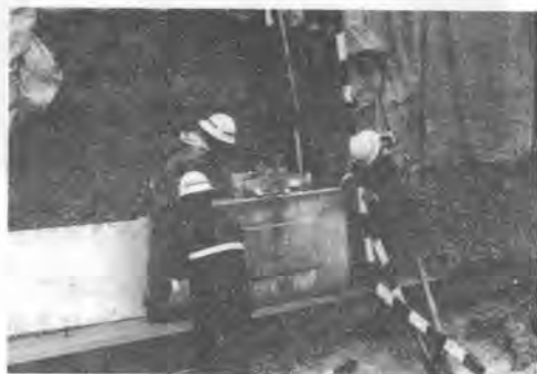
写真-2 π型ブロックの据付状況
