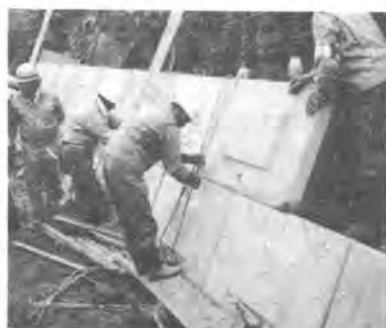
写真-4 固定金具の取付状況
