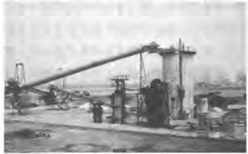
写真-1 実証プラント全景
