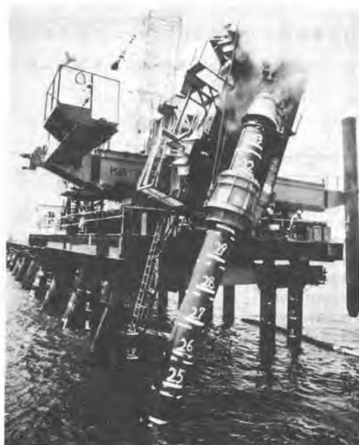
図-3 実証実験中のKST杭打装置
