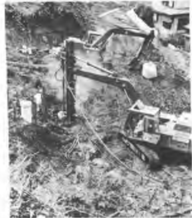
写真-1 混合機全景
