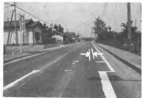
写真-4 国道345号線
