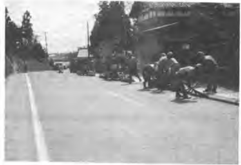
写真-3 施工状況
