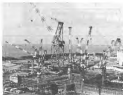
写真-1 浜岡原子力発電所建設工事でのタワークレーン稼働状況
