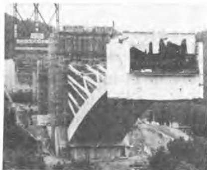
写真-2 宇佐川橋施工中
