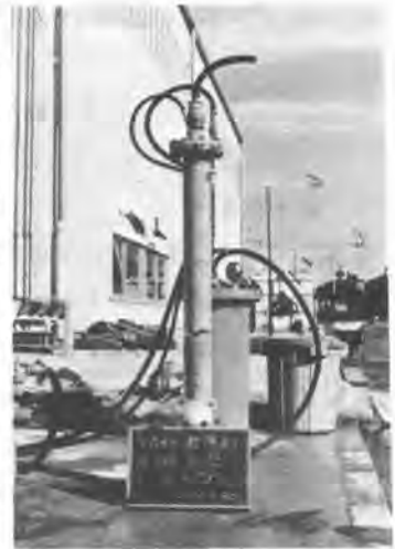
写真-1 模型止水実験
