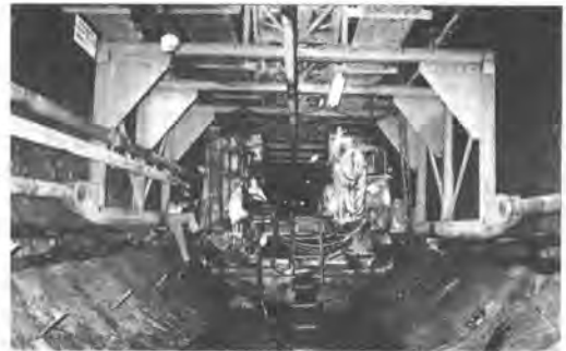
写真-2 インバートセントルとトレンコンベヤー
