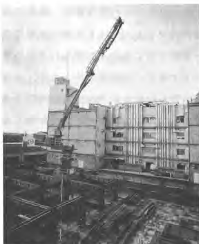
写真-2 クレーン作業全景
