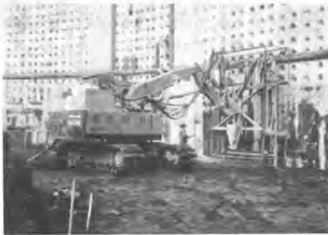
写真-1 現場で稼働中の自動壁面目荒し機
