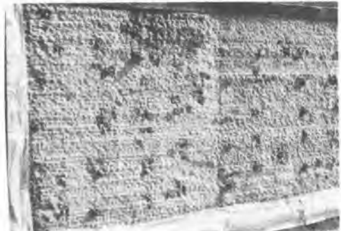
写真-2 目荒し処理後の壁面状態
