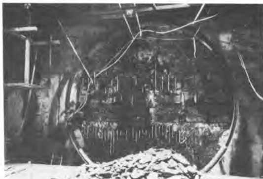
写真-3 連続地中壁の切削
