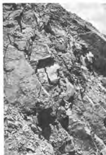
写真4 岩盤の節理状況
