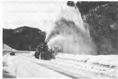
写真-1 ロータリ除雪車拡幅作業
