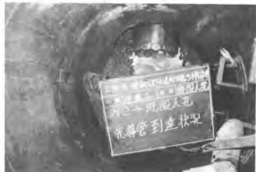
写真-3 到達状況 (既設1号人孔)
