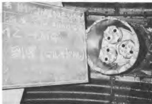
写真-1 到達状況 (先導管+マルチドリル)
