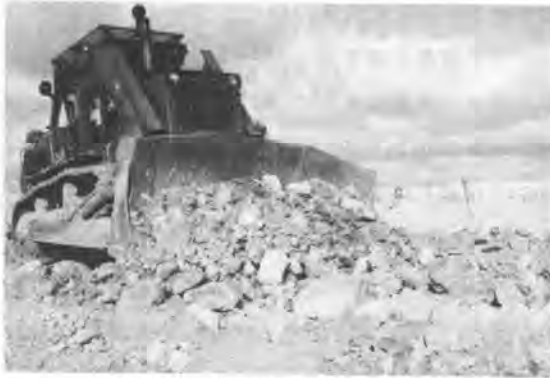
写真4 ドージング掘削状況
