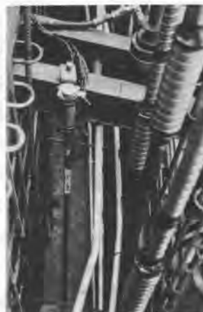
写真3. ヨークに取付けられた温度センサー
