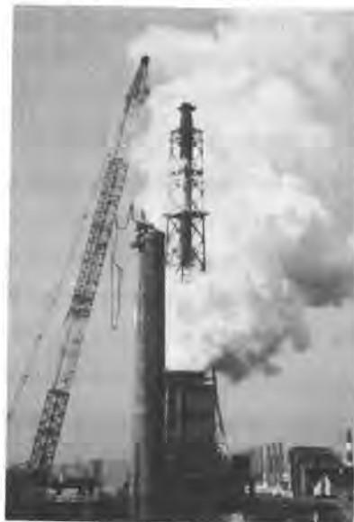
(写真-1) 施工状況
