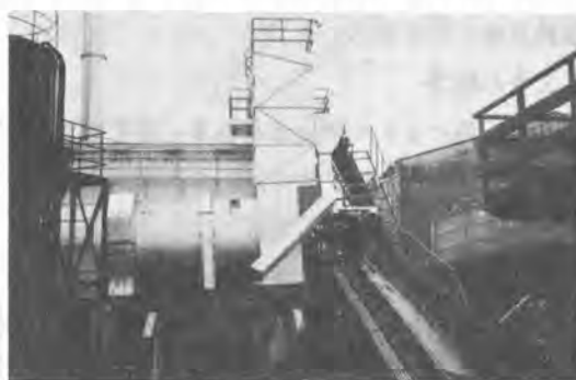
写真-1 工場設置状況
