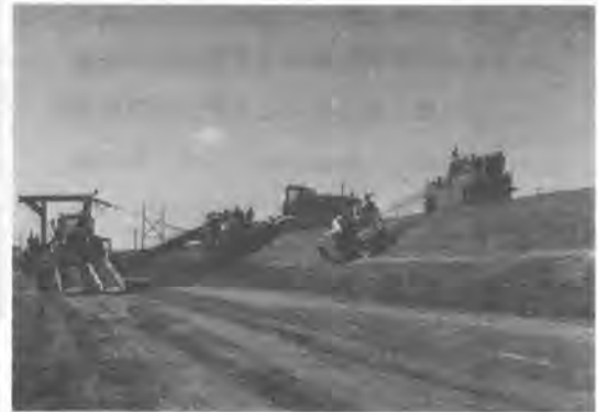
写真-1 施工状況
